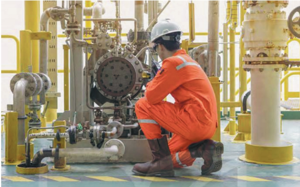
Hình 2.6. Hoạt động bảo dưỡng, sửa chữa thiết bị cơ khí
