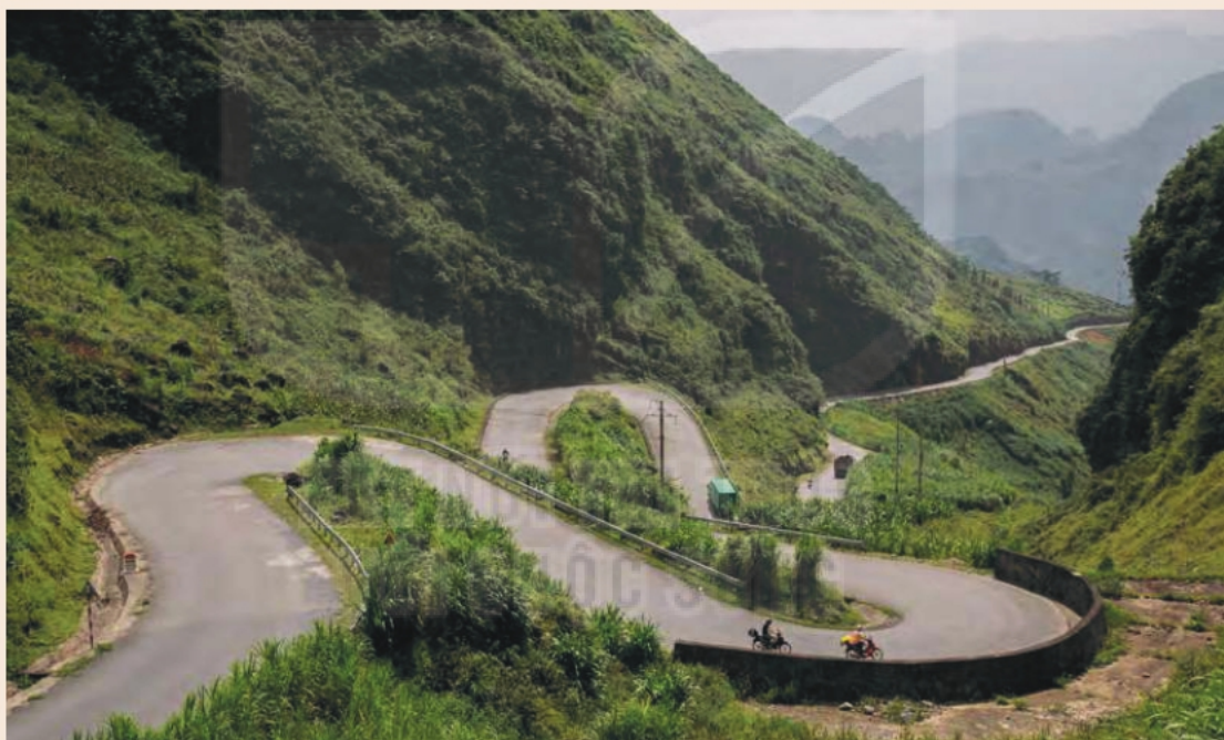
Hình 25.7. Đường đèo dốc dài, quanh co
